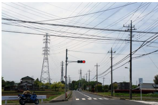
正面に見える道路が通行禁止だった（③路線＝白岡市の区間）
