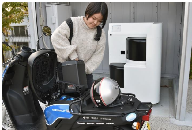
大阪大学に設置されたバッテリー交換機
